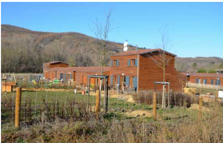
Source : Cerema DTerSO
