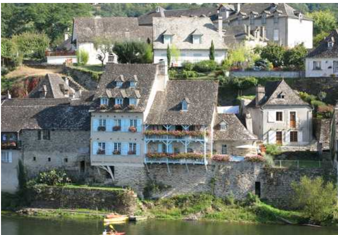
Source : Cerema DTerSO
