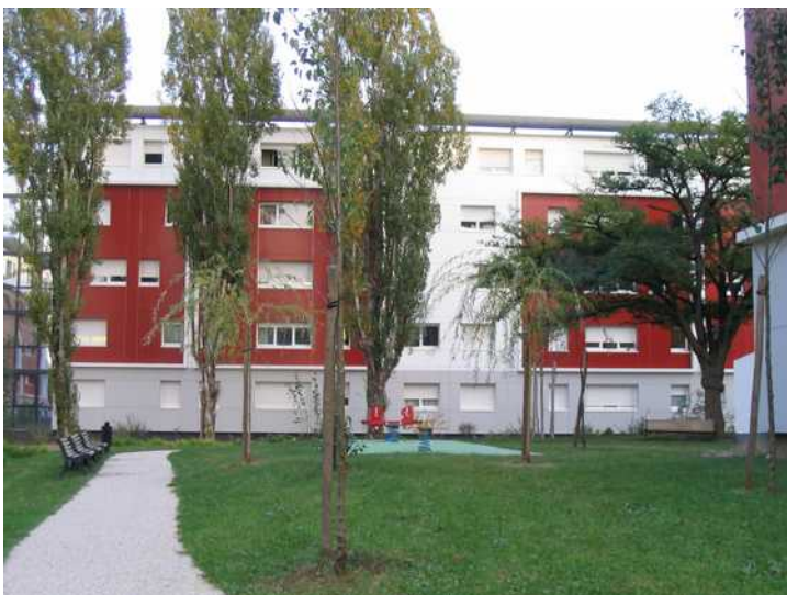
Source : Cerema DTerSO
