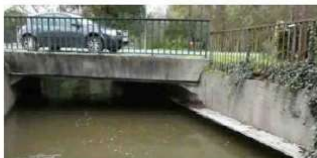
À Azac, un ouvrage permet aux petits animaux de traverser la rivière à pied sec même en période de hautes eaux. PHOTO: CCE
