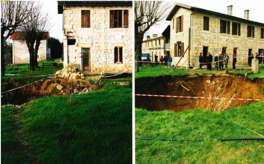
*On notera les dégâts au bâti (angle de la maison déstructuré). Le diamètre du fontis était d'environ 18 mètres.*
