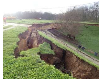
Effondrement de cavité souterraine sur la commune de Naujan-et-Postiac en 2021
