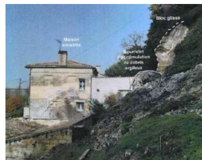
Eboulement sur la commune de Gauriac en 2021 - Crédit photo CEREMA
