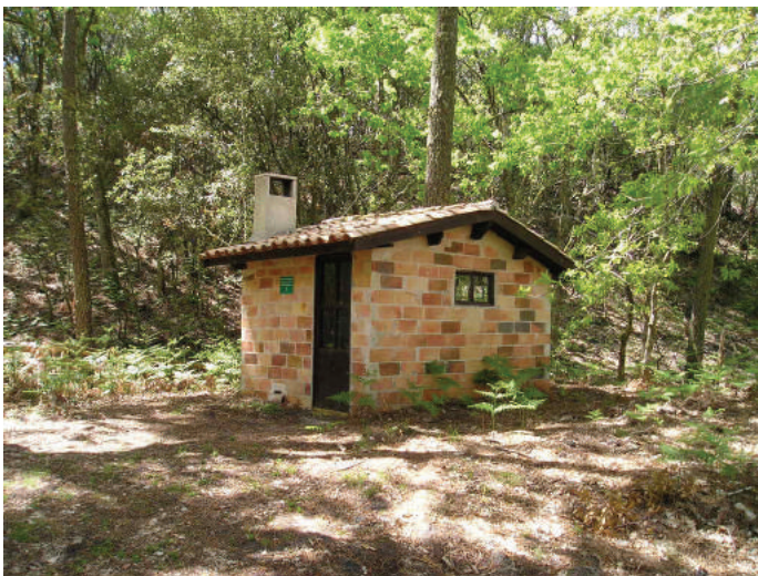
Ancienne cabane de gemmeur (1920) rénovée
